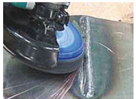
*移除焊接痕跡
